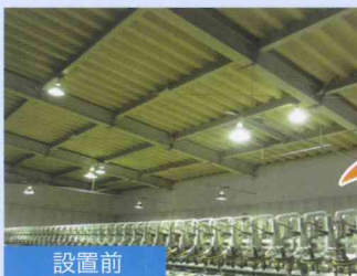
製糸工場（水銀灯から 110W型 LED へ）
