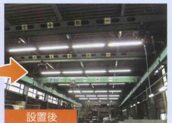
金型工場（水銀灯から 110W型 LED へ 天井高7m）
