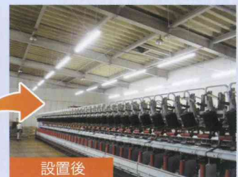
製糸工場（水銀灯から 110W型 LED へ）
