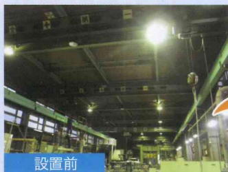
金型工場（水銀灯から 110W型 LED へ 天井高7m）
